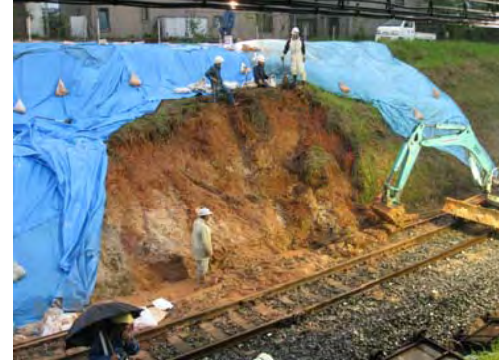
④崩壊土砂撤去完了
