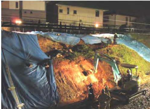
③崩壊土砂撤去
