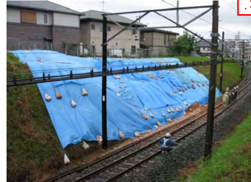
⑤応急復旧完了
