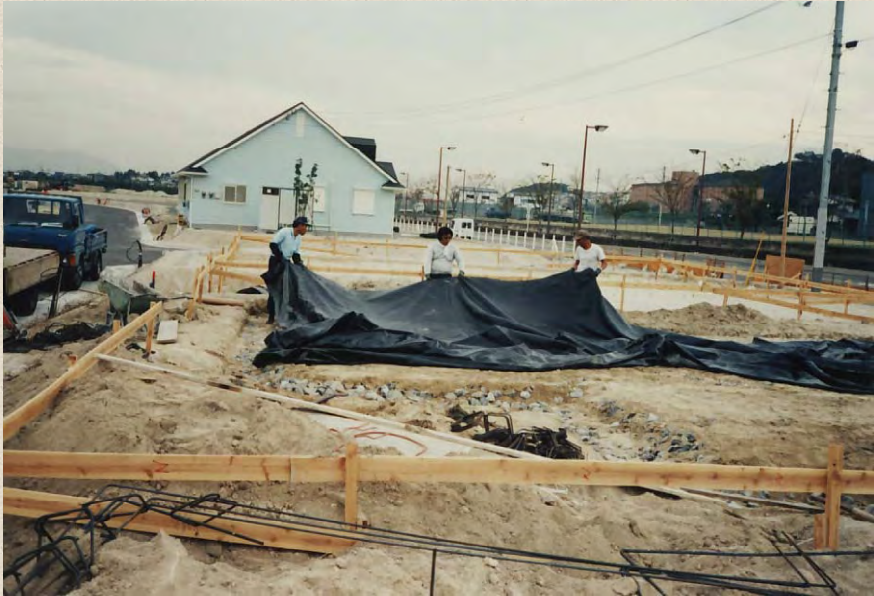
塩化ビニールシートの敷設中（濃集現象の制御）
