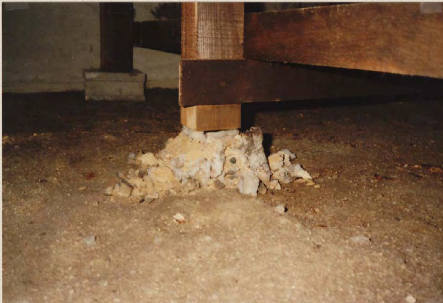
豊浜団地 Floor post footings
