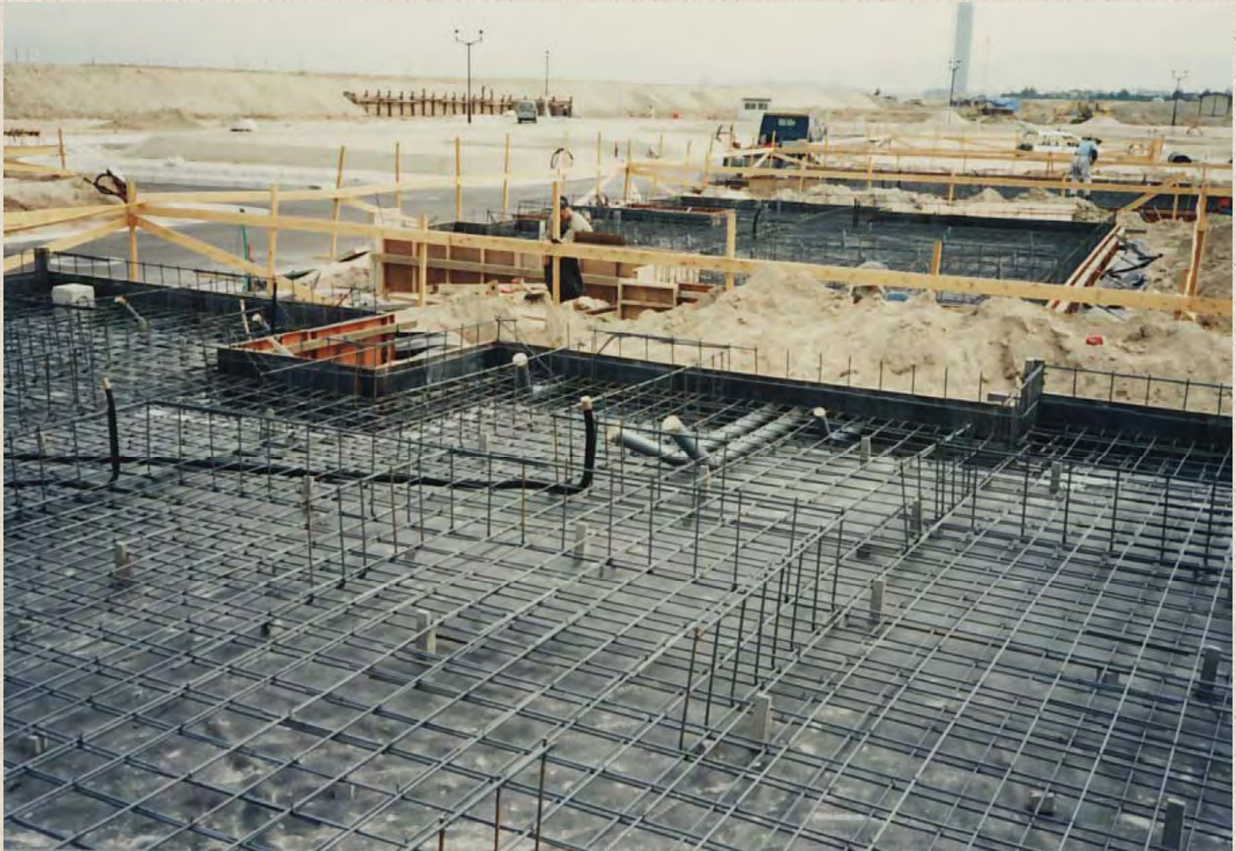
塩化ビニールシート敷設上に床版の配筋
